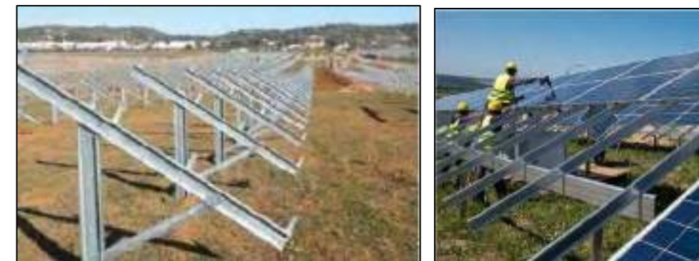
Figure 18 : Exemple de structures porteuses (Source : ABOWIND)
