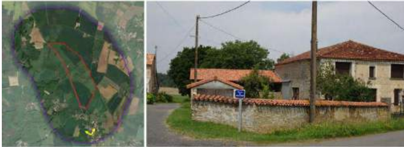
Figure 196 : Photographie du hameau dit le Maine, constitué de plusieurs habitations (Crédit photo : NCA Environnement)
