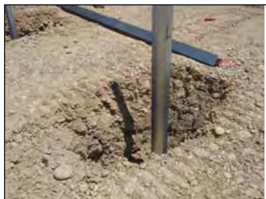
Figure 19 : Types de fondation - pieux battus
