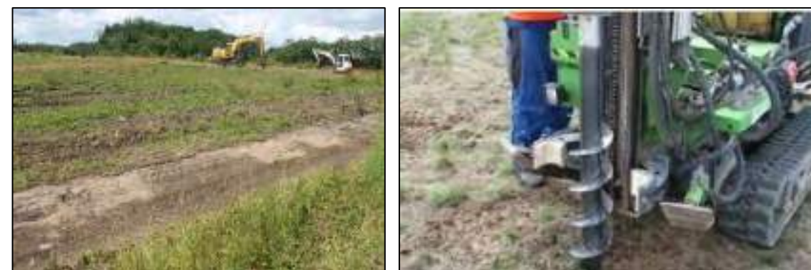
Figure 31 : Exemple de travaux (Source : ABOWIND)
