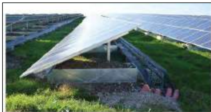
Figure 21 : Fixation par des gabions
