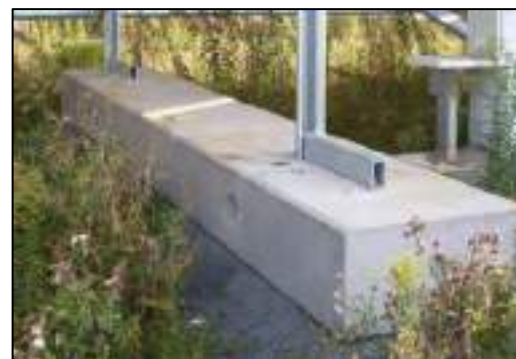
Figure 20 : Type de fondation – semelle béton
